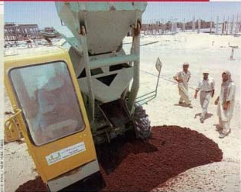
Arbeiter beim Vergraben von Stockosorb-Granulat
